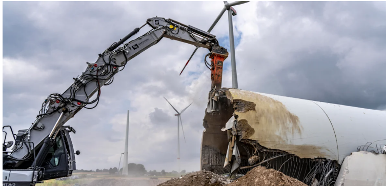
Gesprengter Turm eines 20 Jahren alten Windrads in Werl (Nordrhein-Westfalen)
