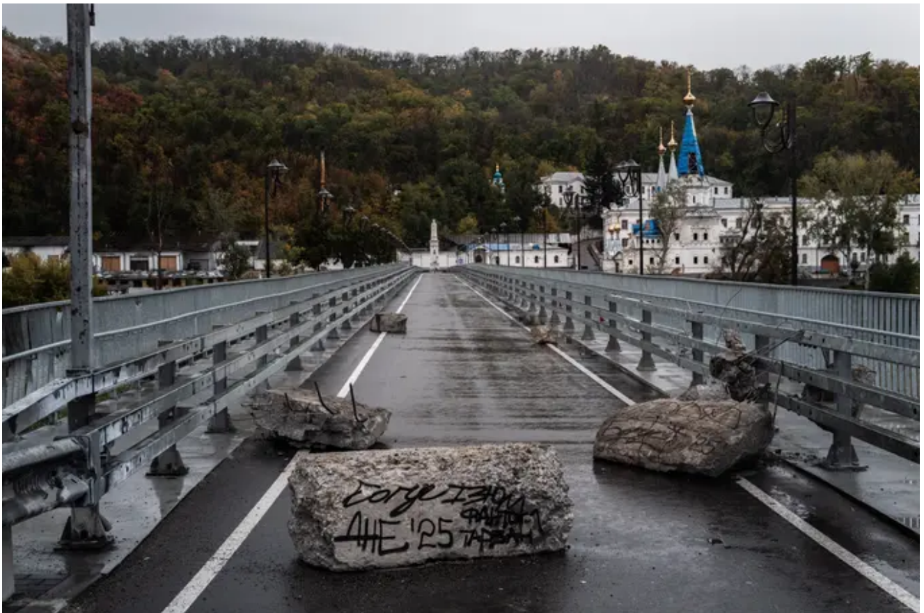
Trümmer aus Beton blockieren die Brücke über den Fluss Donez. 2022 war das Kloster während vier Monaten von der Aussenwelt abgeschnitten.
