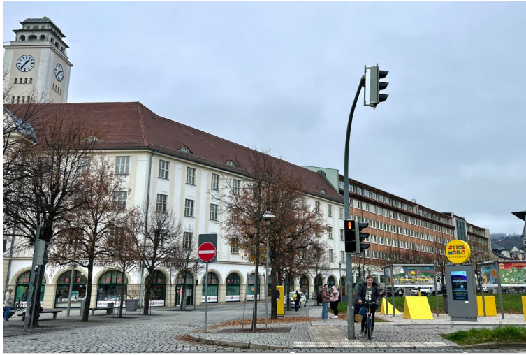
Das Landratsamt Sonneberg ist hinten rechts zu sehen
