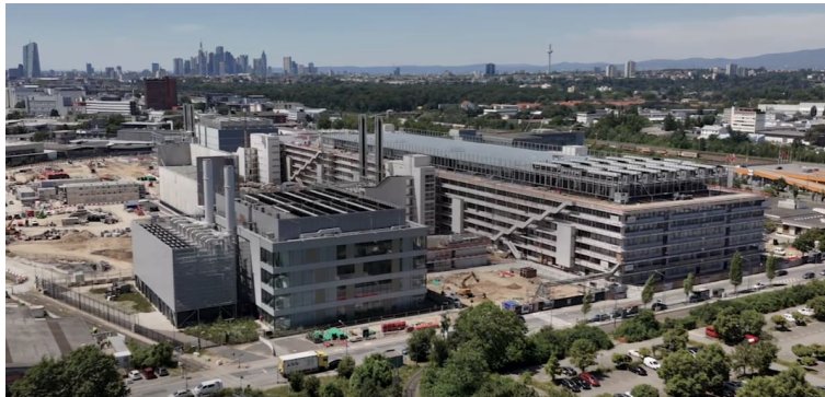
Strombedarf wie ein ganzes Stadtviertel: der im Bau befindliche Digital Park Fechenheim in Frankfurt am Main
